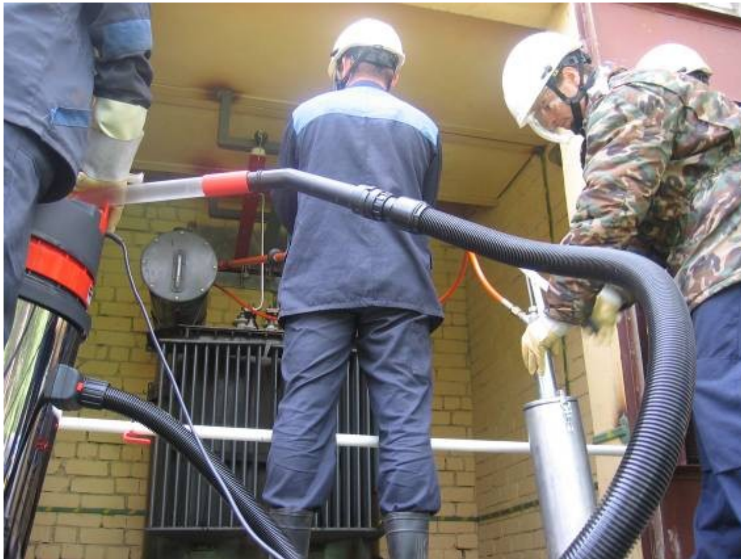
Доливка трансформаторного масла комплектом H092
